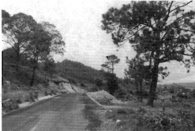
Foto 16. Tramo de carretera reparado, después del deslizamiento de ladera hacia la parte derecha de la foto. Nótese la inclinación del pino grande de la derecha
