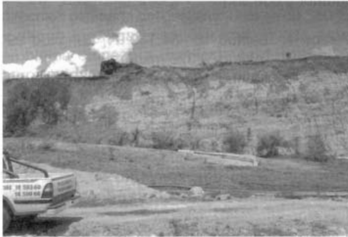
Foto 12. Aquí se observa el bloque que ha caído ya unos 30 metros en un periodo de 10 años. Inicialmente el nivel del bloque inferior estaba a la misma altura del borde donde se encuentra una de las dos casas, ya abandonadas (la otra está fuera de foto a la derecha)
