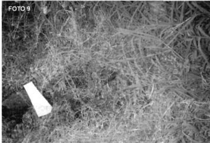
La foto 9, muestra una de las fracturas presentes en el sector de terreno que se ha reportado como próximo a deslizarse. Ésta foto fue tomada viendo hacia el sur
