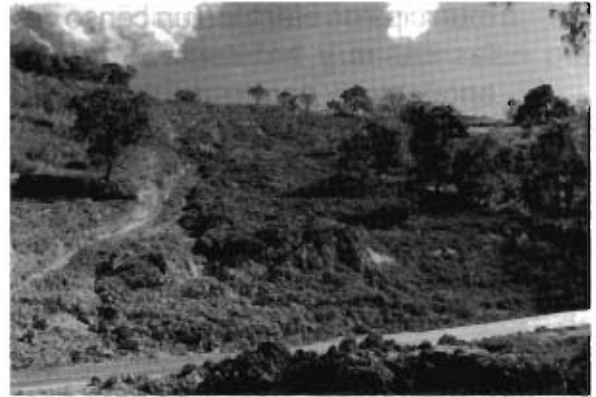
Foto 24. Deslizamiento de material, ocurrido en una ladera de los terrenos de cultivo del ejido de San Martín Coapaxtongo. Nótase la saturación del terreno por agua de lluvia
