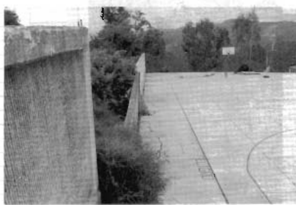
Foto 5. Barda norte de la Escuela Primaria Estatal "20 de Noviembre", que muestra una deformación clara
