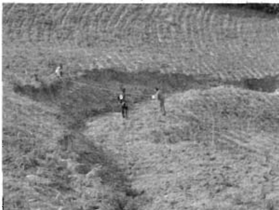
Foto 22. Medición de los desplazamientos horizontales y verticales en la corona del bloque deslizante
